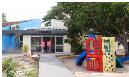
Figura 7: Centro de Educação Básica - Creche UEFS
